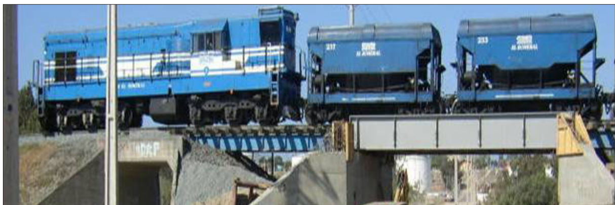
Nuevo Paso sobre nivel Guayacán
