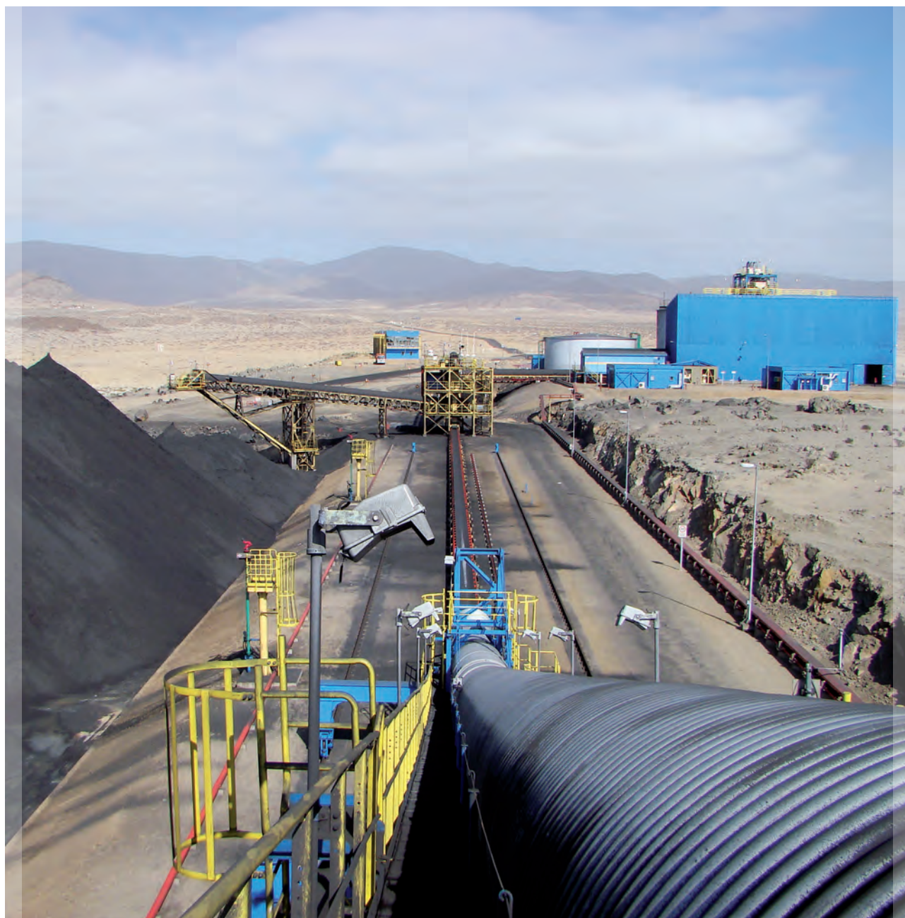
Cancha Almacenamiento Puerto Punta Totoralillo
