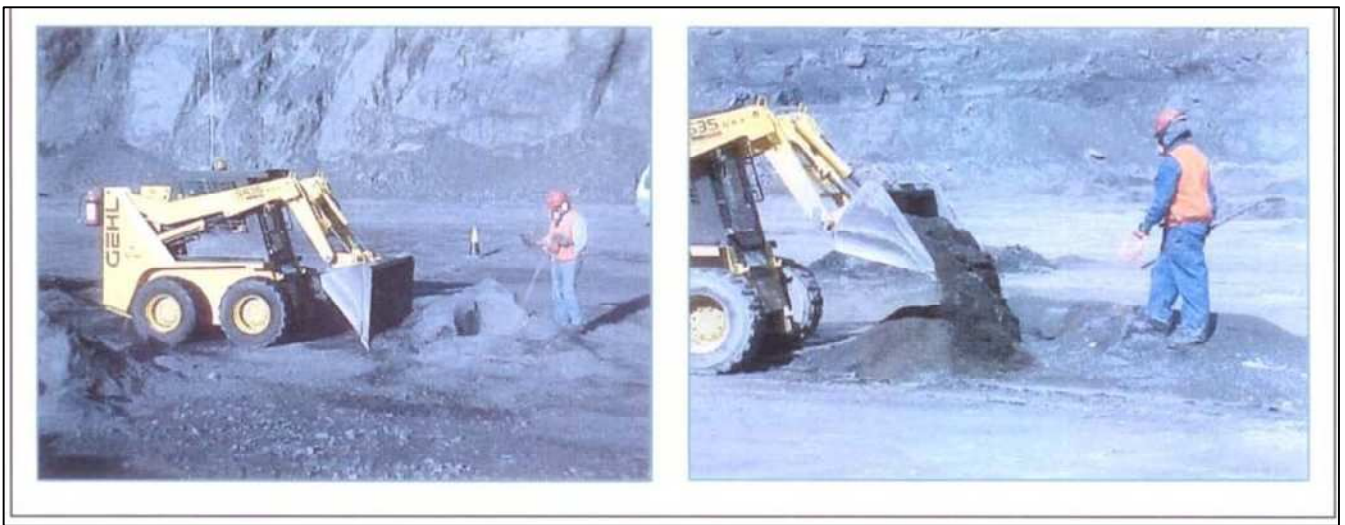
Figura 3: Tapado de pozos
