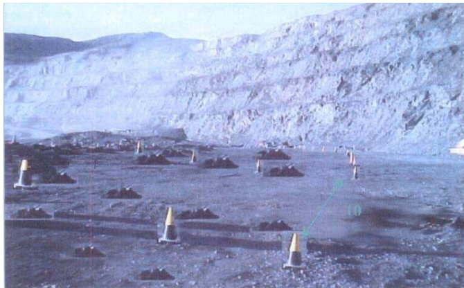
Fig.7: Sub-área para ingreso de perforadora
