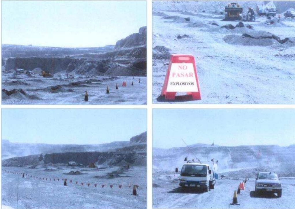
Fig.2. Señalización de área de carguío de explosivos
