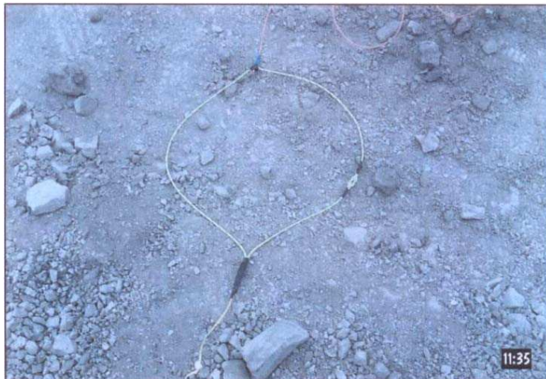
Fig. 6: Instalación correcta de “back up” en detonador pirotécnico.
